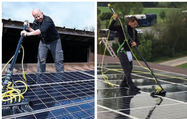
HiFlo CarbonTec System die Reinigung von Solarmodulen einfach, schnell und effektiv.
