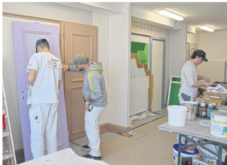
Auszubildenden die fachgerechte Untergrundvorbereitung, die korrekte Einstellung der Spritzviskosität der Farbe, die Prüfung des Spritzbildes, das richtige Handling mit der Spritzpistole und den gleichmässigen Farbauftrag.
